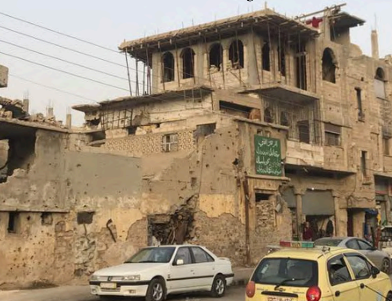
Gebäude der Eltern nach dem Krieg beim Wiederaufbau
